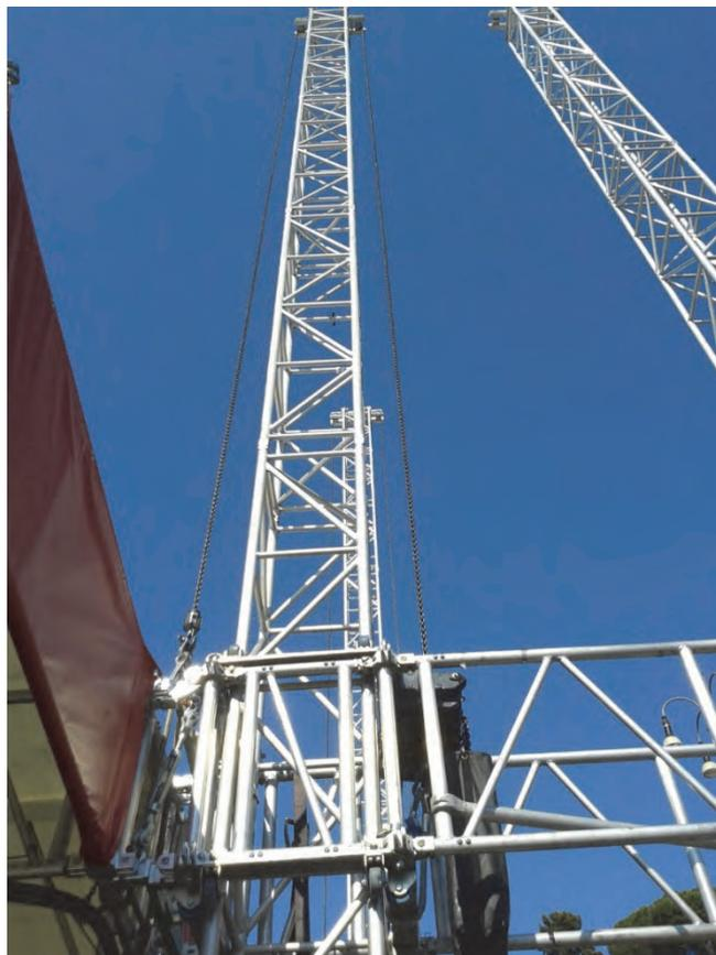
Figura 1.3 – 3 Esempio di sistema di sollevamento della copertura
