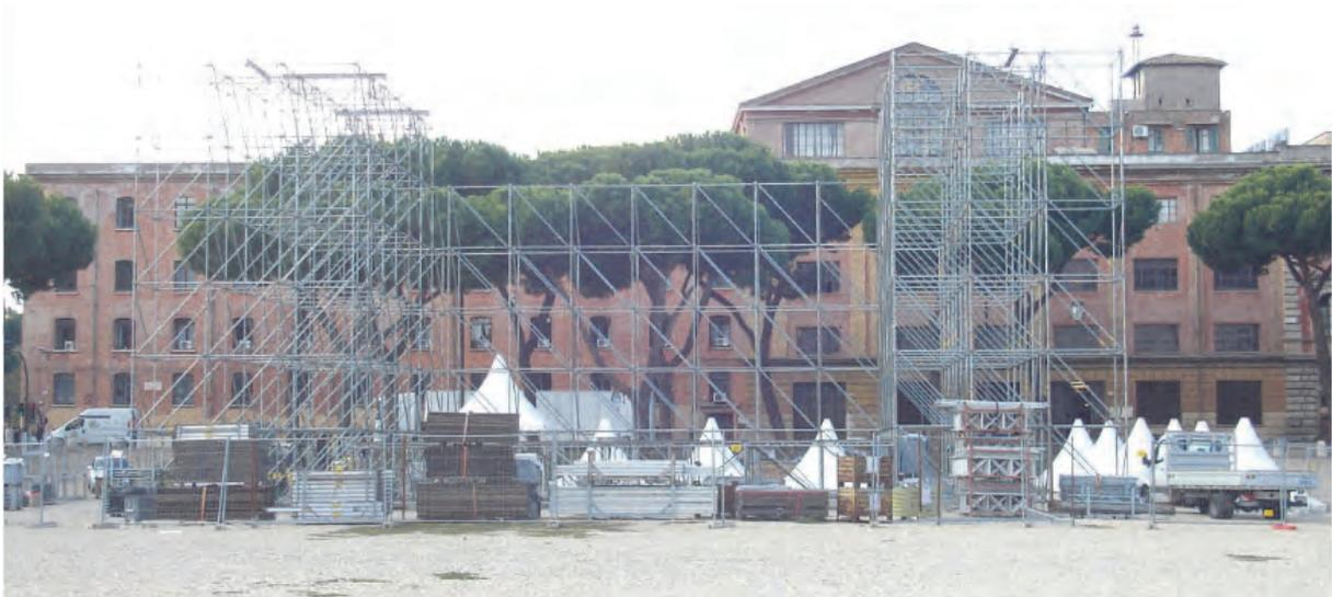
Figura 1.4 – 9 Esempio di palco (pedana e strutture verticali) realizzato con elementi di ponteggio multidirezionale
