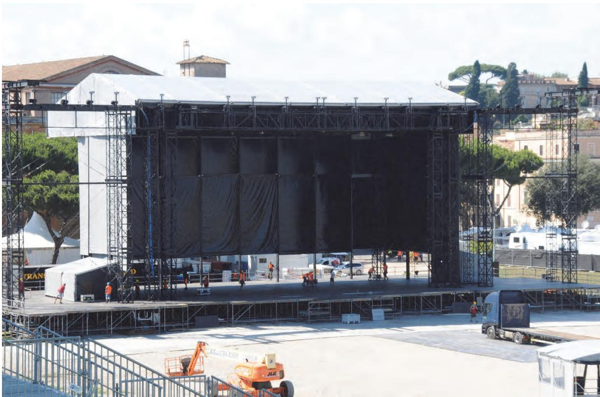
Figura 1.4 – 10 Esempio di palco (pedana e strutture verticali) realizzato con elementi tralicciati
