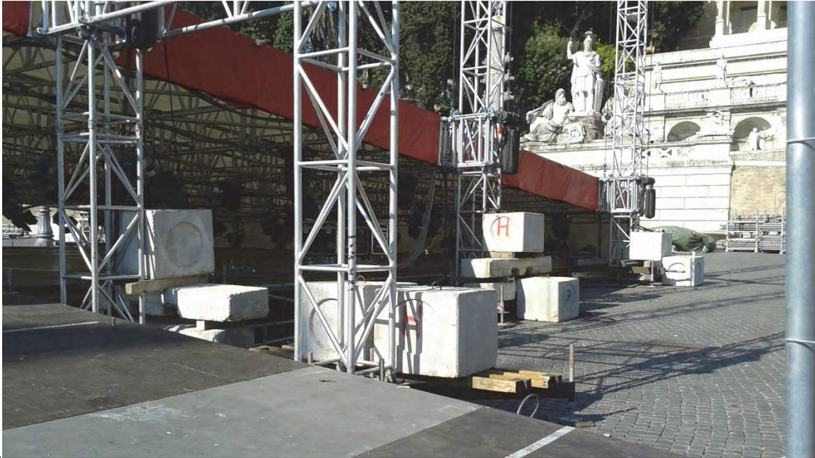
Figura 1.3 – 4 Esempio di posizionamento della zavorra
